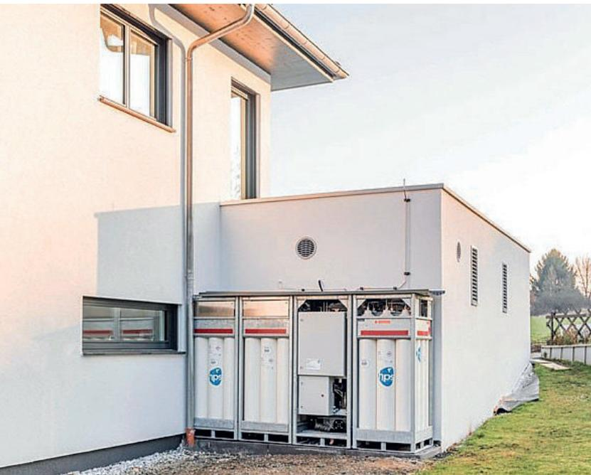
Anwendung eines Energiespeicher-Wasserstoffsystems von HPS. (homepowersolutions.de)
