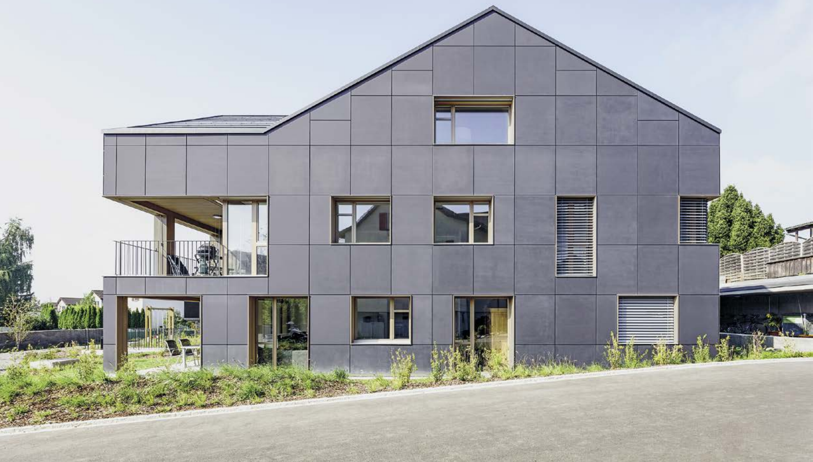
Dieses Mehrfamilienhaus in Brütten verfügt über keinen Anschluss ans öffentliche Stromnetz, sondern produziert den Eigenbedarf der Bewohner für Haushalt und Mobilität selbst. (Bild: Umwelt Arena)
